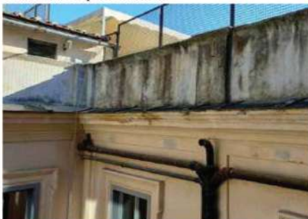
Particolare copertine ardesia
